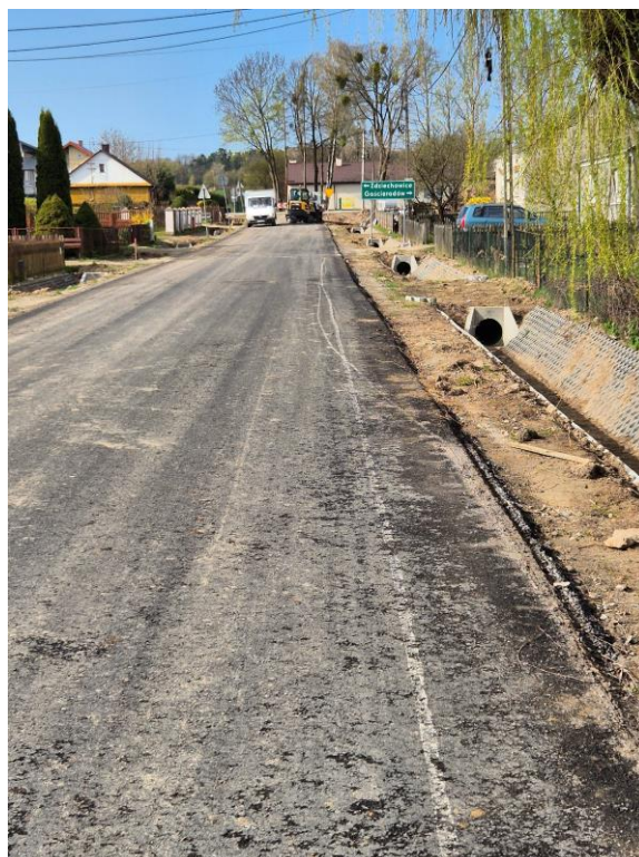
Fot.6. Inwestycja w trakcie realizacji- Przebudowa drogi powiatowej nr 2715L w ramach inwestycji „Poprawa infrastruktury drogowej w powiecie kraśnickim” – odcinek w miejscowości Salomin
