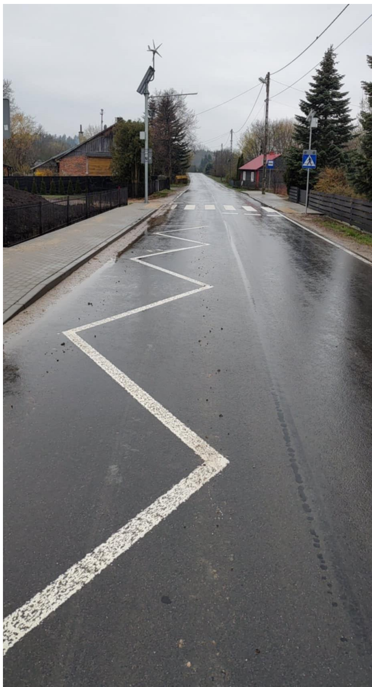
Fot.5. Przebudowa drogi powiatowej nr 2644L Bliskowice-Księżomierz-odcinek zabudowany
