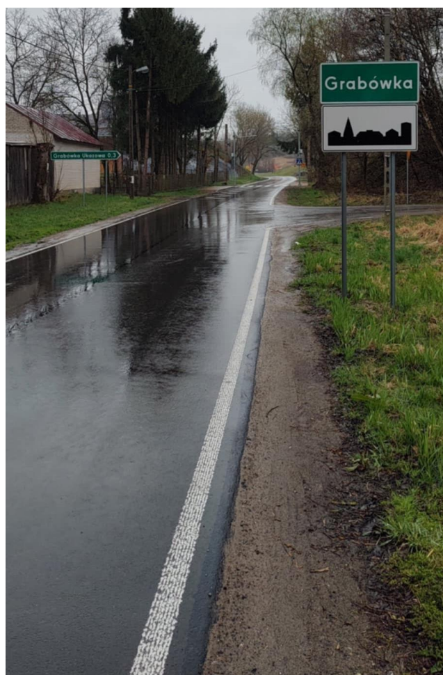
Fot.3 Przebudowa drogi powiatowej nr 2644L Bliskowice-Księżomierz- odcinek w Grabówce
