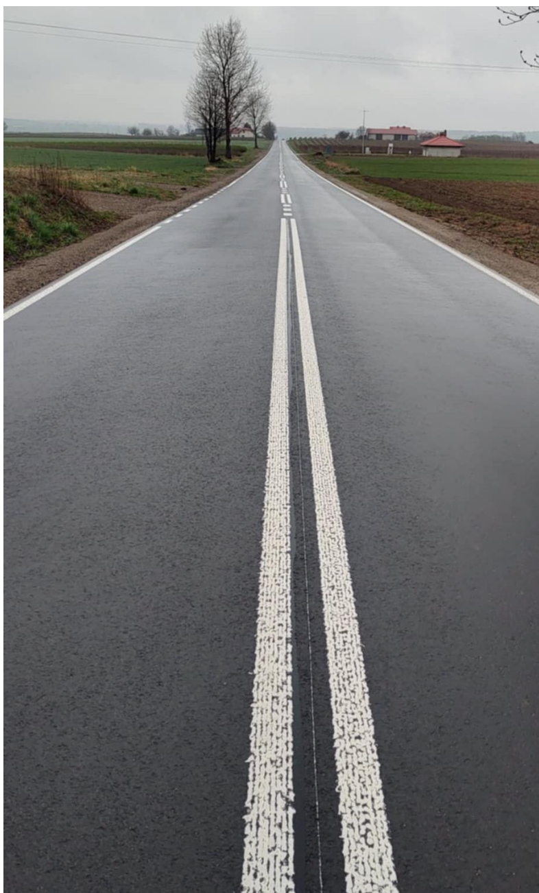
Fot. 1 Przebudowa drogi powiatowej nr 2250L odcinek Zadworze- Józefin
