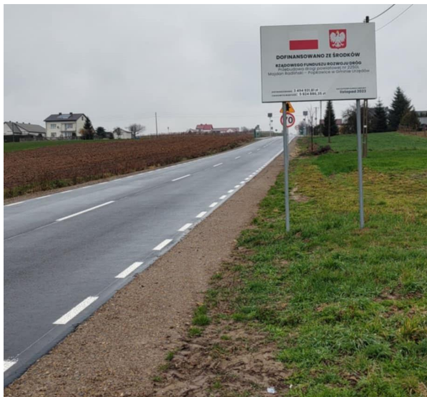
Fot. 2 Przebudowa drogi powiatowej nr 2250L odcinek Zadworze- Józefin- początek odcinka
