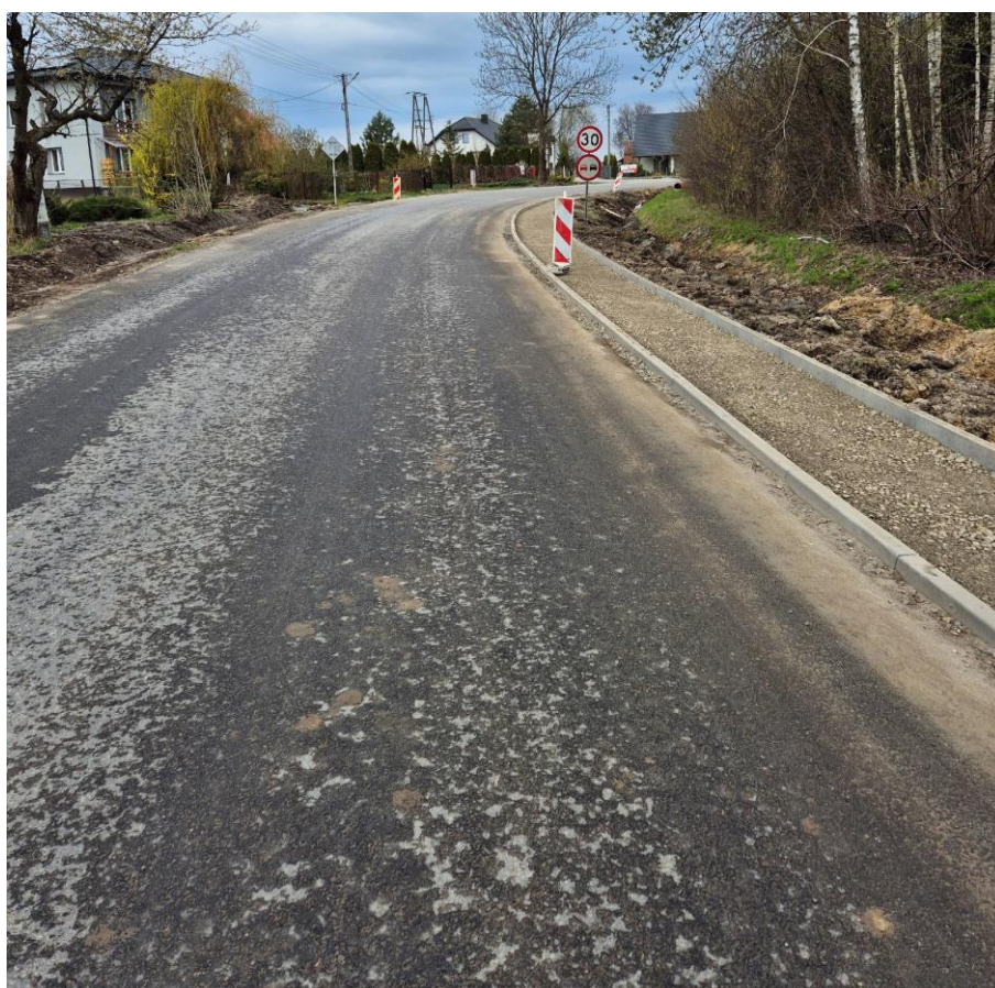
Fot.7. Inwestycja w trakcie realizacji- Przebudowa drogi powiatowej nr 2738L w ramach inwestycji „Poprawa infrastruktury drogowej w powiecie kraśnickim” – odcinek w miejscowości Blinów
