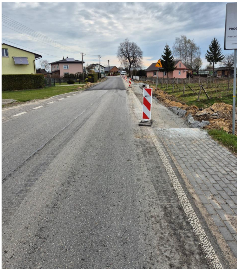
Fot.8. Inwestycja w trakcie realizacji- Przebudowa drogi powiatowej nr 2740L w ramach inwestycji „Poprawa infrastruktury drogowej w powiecie kraśnickim”– odcinek w miejscowości Polichna Czwarta
