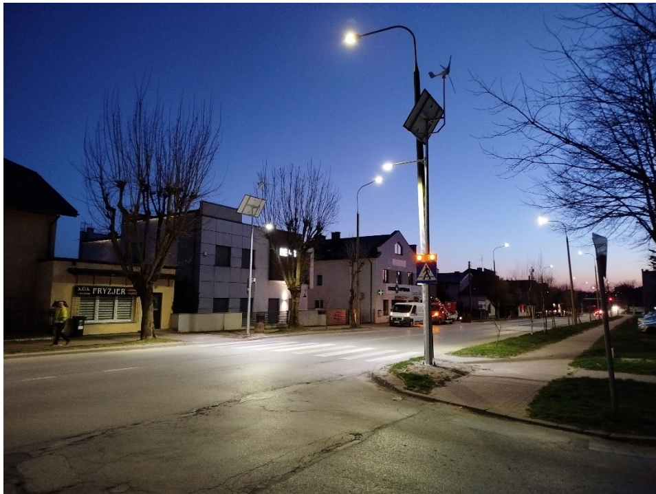
Fot.1. Przejście dla pieszych ul. Słowackiego w Kraśniku
