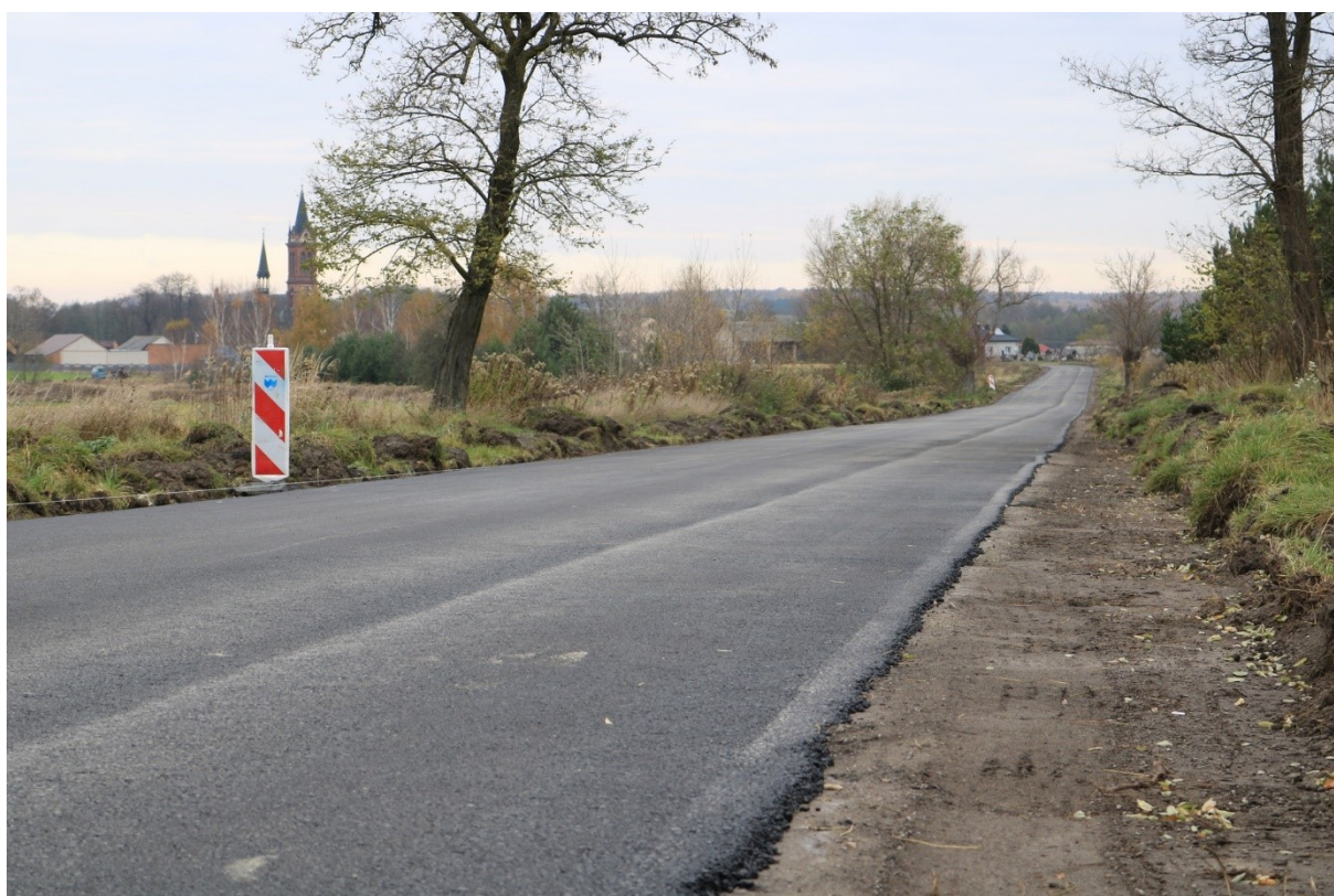
Fot.4. Remont drogi powiatowej nr 2712L w miejsc.Szczecyn (gm.Gościeradów)
