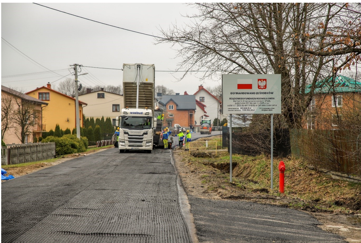
Fot.7. Remont drogi powiatowej nr 2743L w miejsc. Polichna i Huta Józefów (gm. Szastarka)
