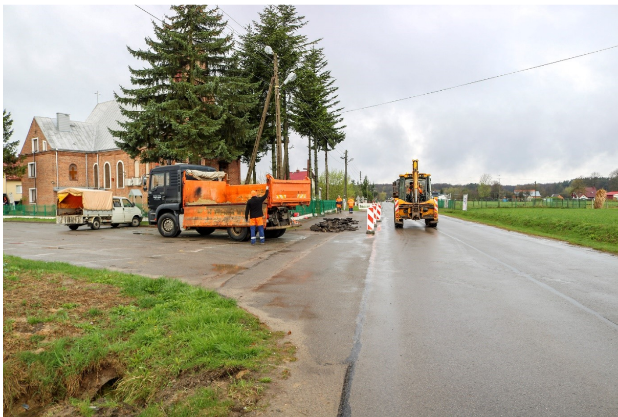
Fot. 3 Budowa chodnika przy drodze powiatowej nr 2737L w miejsc.Szastarka
