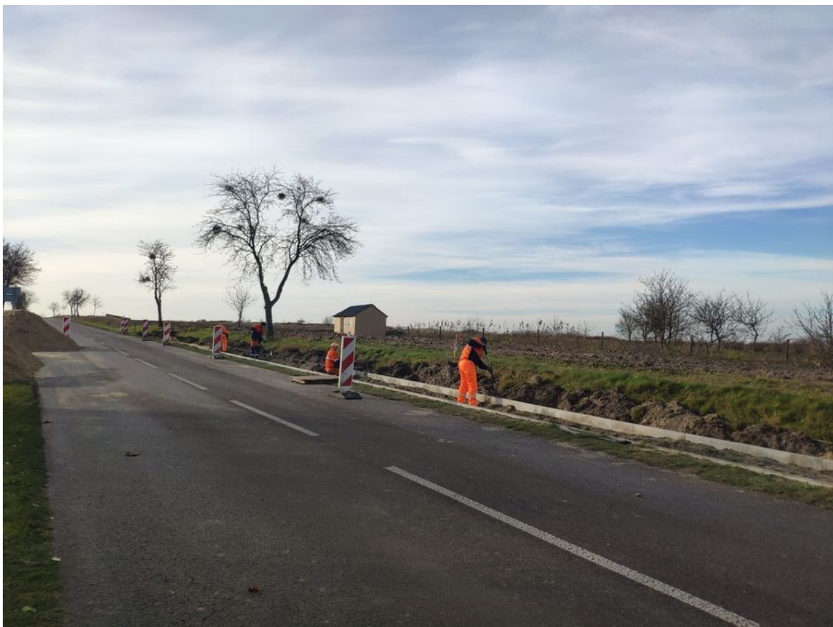
Fot. 9 Budowa chodnika w miejsc.Rachów
