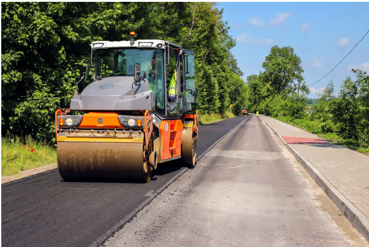
Fot.10. Przebudowa drogi powiatowej nr 2639L w gminie Dzierzkowice
