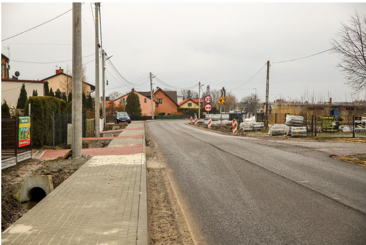
Fot.5. Przebudowa drogi powiatowej nr 2289L w miejsc. Szastarka
