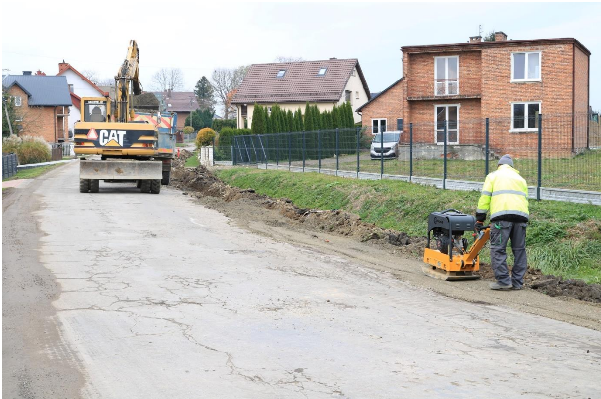
Fot.8. Remont drogi powiatowej nr 2743L w miejsc.Polichna i Huta Józefów (gm.Szastarka)
