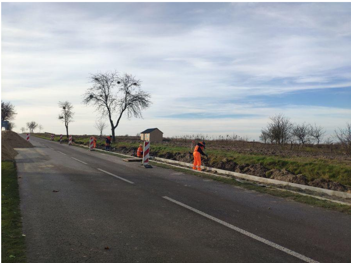
Fot. 9 Budowa chodnika w miejsc.Rachów
